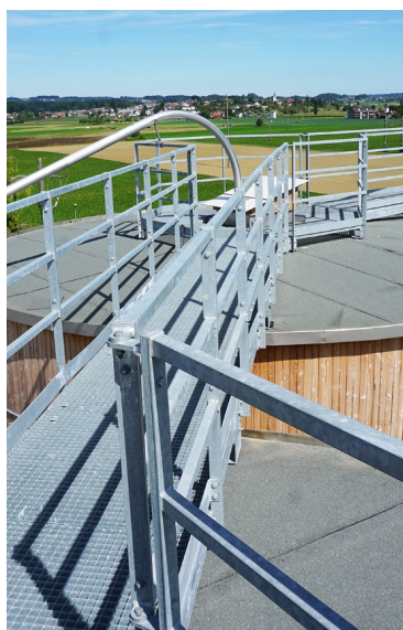
Rundsilos mit je 400m 3 Volumen aus Lärchenholz
