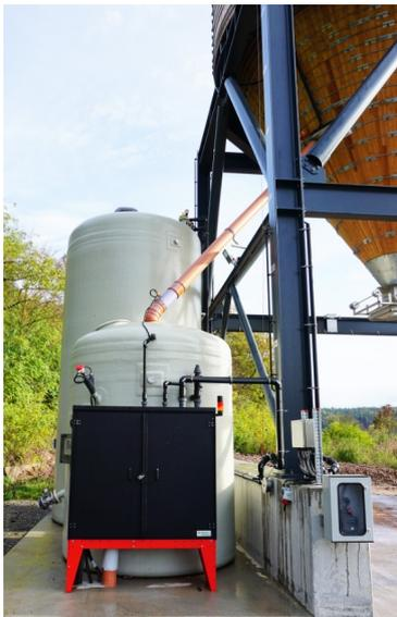
Plateforme de contrôle duplex avec toit et pare-vent
