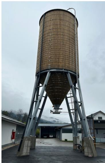
Sortie de silo avec vanne à double segment, vanne de secours pour révision et manche à air réglable en hauteur
