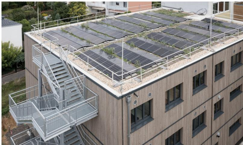
Les 42 modules en bois ont été préfabriqués dans notre usine de Grossenlüder et assemblés sur place en quelques jours seulement pour former un bâtiment de trois étages.
