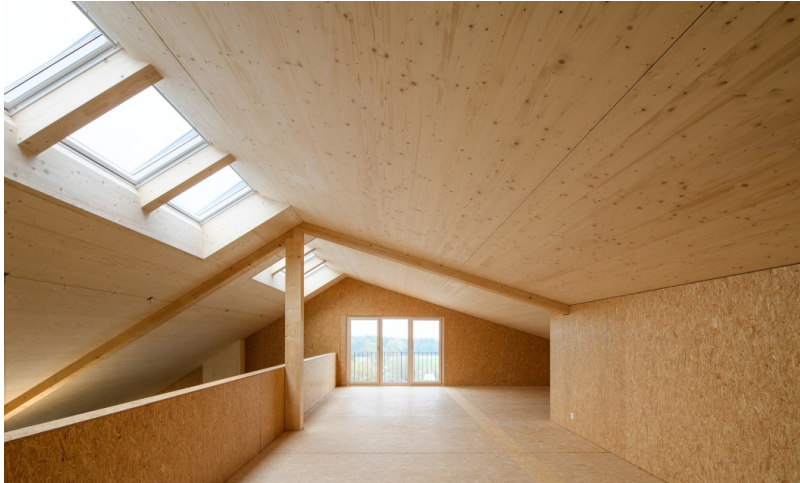
Agrandissement d'une charpente en bois d'épicéa
