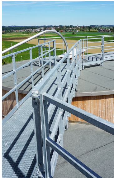
Rundsilos mit je 400m 3 Volumen aus Lärchenholz
