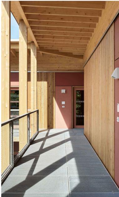
Die beiden Baukörper des Holzmodulbaus werden durch Laubengänge erschlossen und miteinander verbunden.
