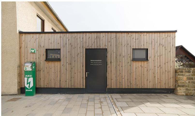
Harmonische Ergänzung: Mit seiner Fassade aus unbehandelter, gehobelter Thermokiefer integriert sich der Holzmodulbau auch farblich gut in die Umgebung.
