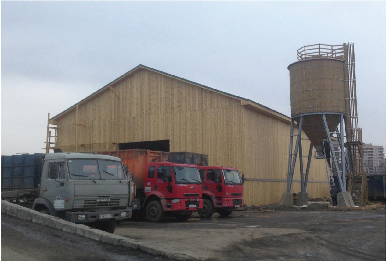
Der runde Silo wurde auf V-förmigem Stahlunterbau erstellt.
